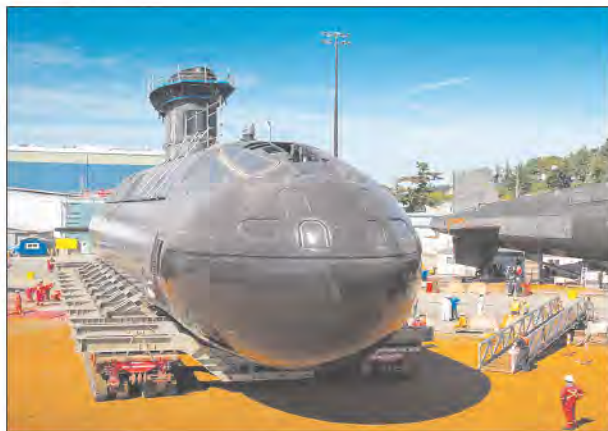
Подводные лодки типа «Виктория» во время ремонта
