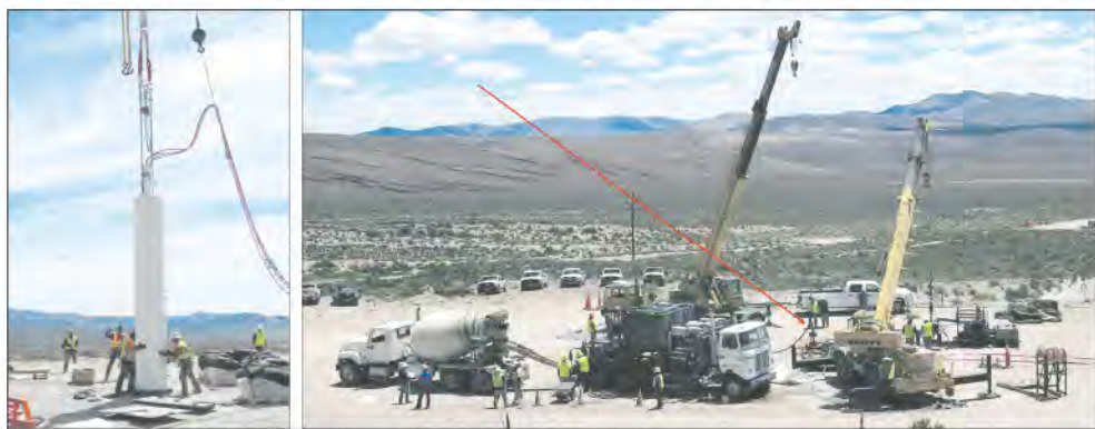
Установка контейнера с зарядом взрывчатого вещества в скважину на Невадском полигоне (программа SPE)
